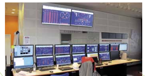
På hver side af rummet op mod storskærmen er der installeret yderligere 2x1 55" LED-skærme, samt i alt 49x23" LCD-skærme, der udgør operatørernes arbejdspladser.
